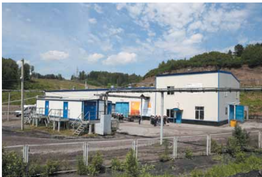
Очистные сооружения шахты «Ерунаковская VIII»
